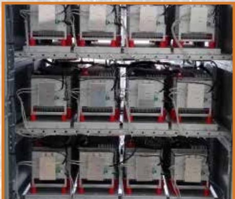
超级电容管理系统, 实现电容组的监控、管理、保护等功能。
