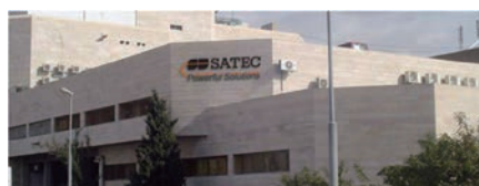
SATEC Ltd. 以色列耶路撒冷 工厂
